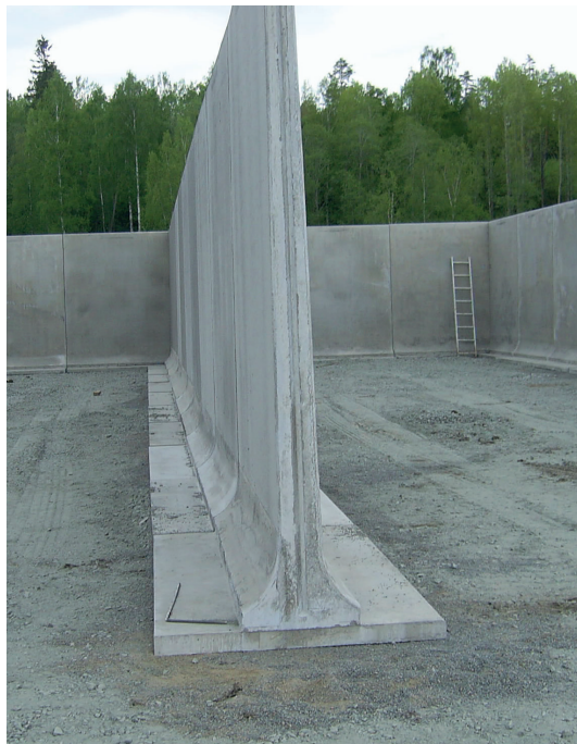
Vinninga Plansilo under montage
