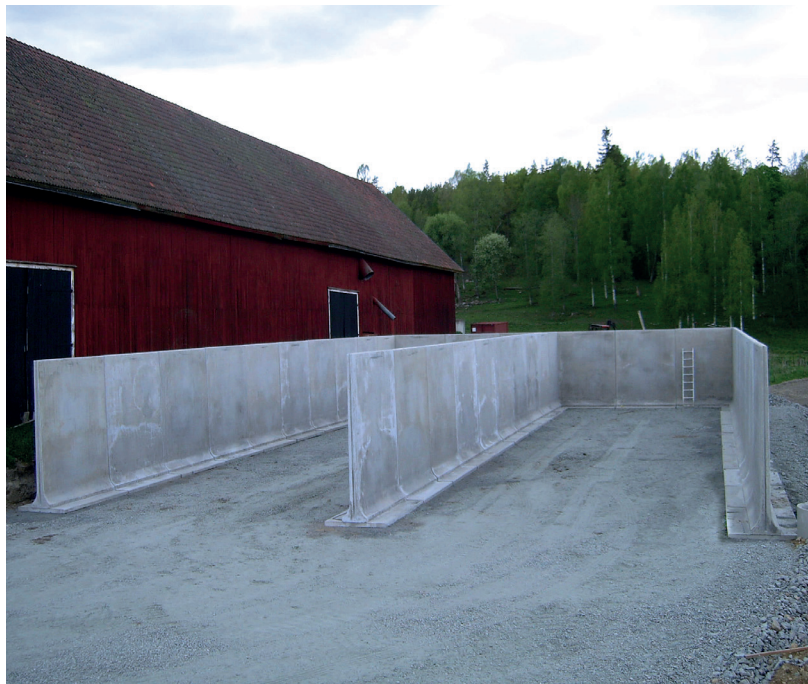
Vinninga Plansilo monterad. Redo för armering och gjutning av platta.
