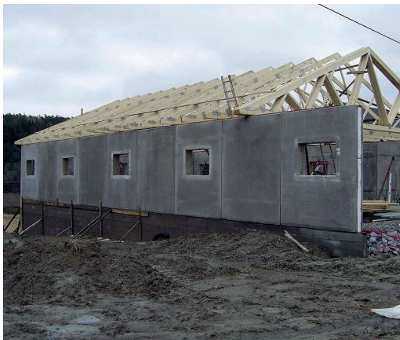
Montage av väggar till stall.
